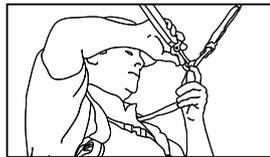
Das ABS AirAnchor-System ermöglicht dem Arbeiter, seinen Anschlagpunkt zu wechseln, ohne sich dazu am jeweils aktuellen Punkt auszuhängen, wodurch der unterbrechungsfrei gesichert bleibt.
