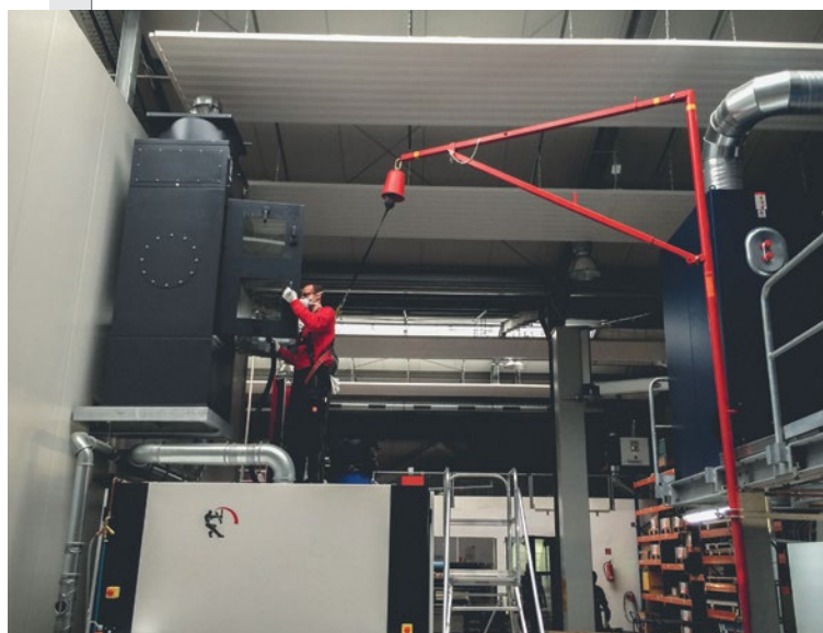
ABS AirAnchor bei der Maschinenwartung - Stahlklemmen ermöglichen eine einfache Montage am Träger
