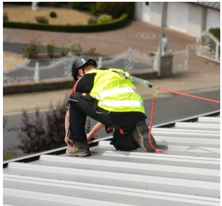
Der D-Ring am Rücken ermöglicht die Befestigung eines Verbindungsmittels für die optimale Positionierung an Absturzkanten.
