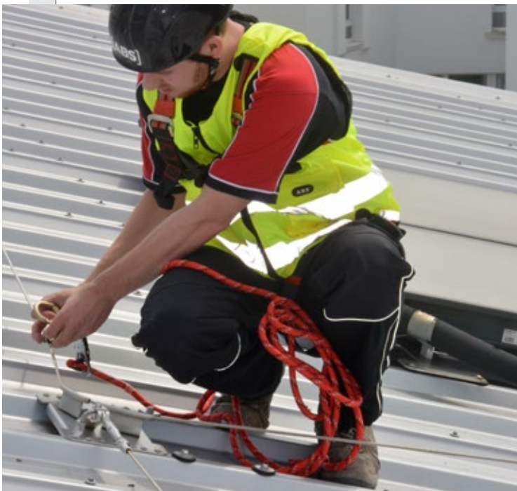
Dank reflektierendem Obermaterial sind in der Höhe arbeitende Menschen auch bei mäßigem Licht gut sichtbar.
