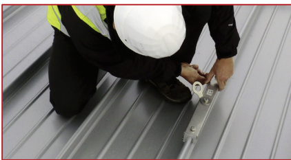
Komplette Anbringung an nur einer Schare.
